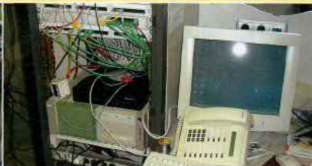
Serwer firmy Gira sterujący wszystkimi funkcjami domu przeważnie konfigurowany jest przez specjalistę, a nie użytkownika.
