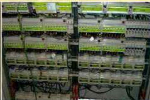
Przypisanie danemu włącznikowi funkcji aktywowania wybranego urządzenia jest konfigurowane w jednym miejscu.
