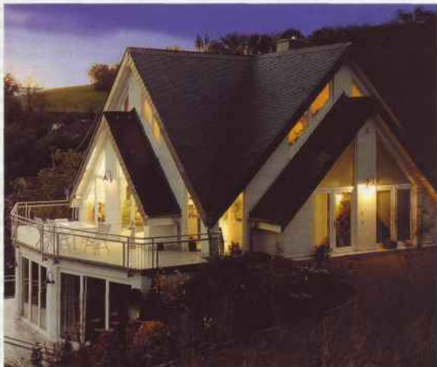
Po wykryciu intruza system może zapalić światła w całym domu w celu zaalarmowania sąsiadów
